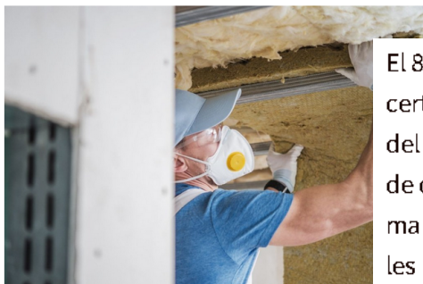
La millora de l'aïllament és una de les mesures a aplicar en la rehabilitació energètica (foto: Aj. Rubí)
